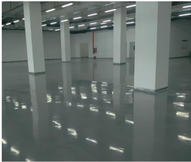
聚脲防水涂料SprayPolyuredWaterproofingCoating是引进国外技术，结合国内重点项目施工工艺要求研发的一种无溶剂、无污染、高反应型防护涂料。产品说明本品是一种A+B双组分、无溶剂、快速固化的绿色环保弹性防水材料，依据成膜反应基团不同而分为高弹喷涂（纯）聚脲防水涂料JNC和高弹喷涂聚氨酯（脲）（俗称半聚脲）弹性防水涂料NJ。按物理性能分为I型和II型。A+B组分在喷涂设备的喷枪内混合喷出，快速反应固化生成弹性体防水膜。高弹喷涂（纯）
